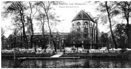
Das Insel-Restaurant Abtei wurde im Stil einer schottischen Klosterruine errichtet
