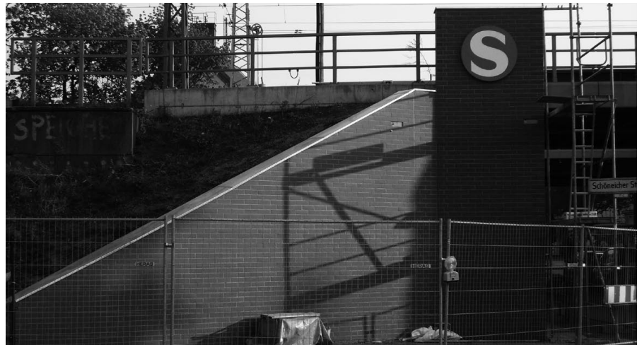
Im April wurde mit der Verklinkerung der Betonwände am S-Bahnhof begonnen.
