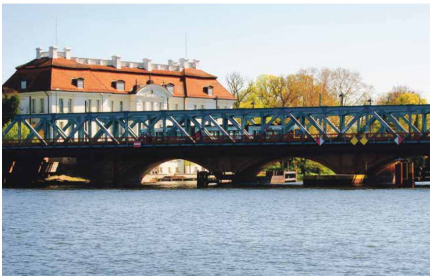
Die Lange Brücke über die Dahme. Die Instandsetzung der zweiten Behelfsbrücke soll im Sommer 2021 beginnen.
